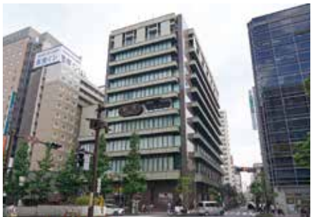
川崎信用金庫本店(川崎市川崎区砂子2-11-1)の脇を通る東海道。稲毛神社の方からこの地を見ると若干の高低差がある
